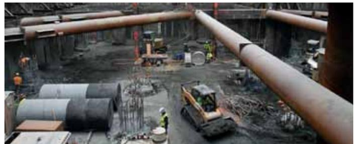
Subgrade preparation for mat pour beneath level 4 bracing
