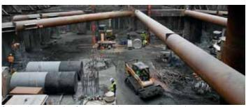
Subgrade preparation for mat pour beneath level 4 bracing
